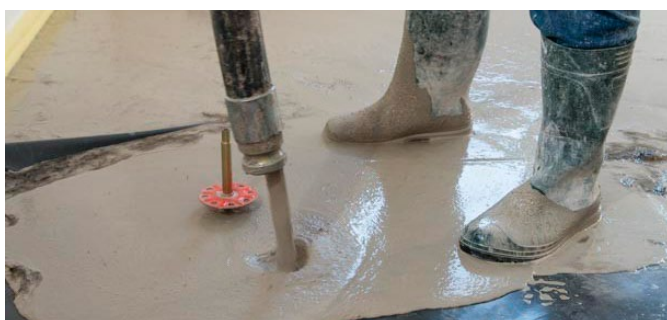
Układanie jastrychu weber.floor FLOW
