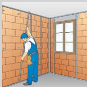
rys. 2 Mocowanie profili CD60 ULTRASTIL
