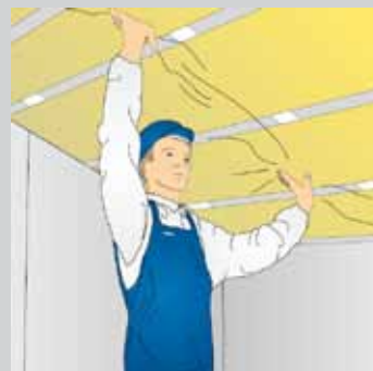
rys. 3 Przyklejanie folii paroizolacyjnej do profili za pomocą taśmy dwustronnej
