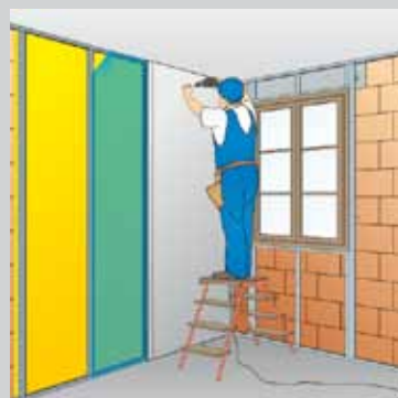
rys. 3 Zamocowanie izolacji
