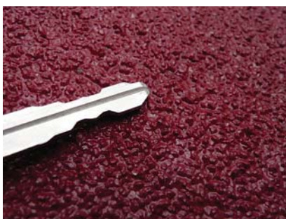
Fot. 2. Widok antypoślizgowej powierzchni ścieżki rowerowej
