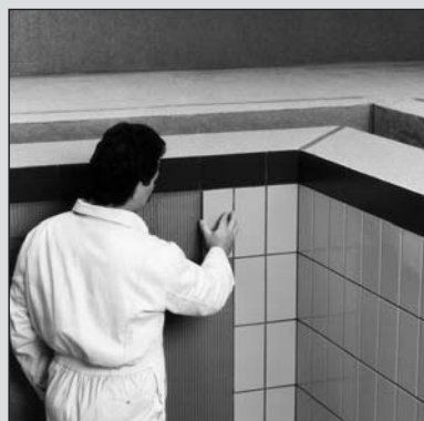
Klejenie i spoinowanie okładzin ceramicznych
