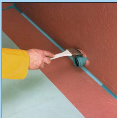
Uszczelnianie przejścia rurowego
