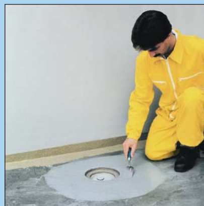
Obrabianie wpustu podłogowego
