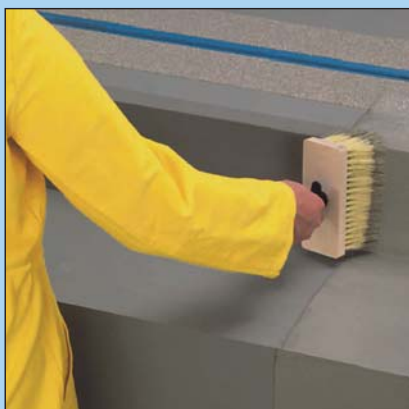
Nakładanie uszczelnienia z SUPERFLEXU 1
